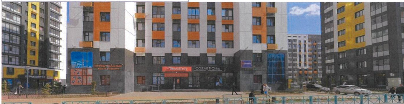
Қасбеттердің қазіргі жағдайының фотосуреті Фотофиксация текущего состояния фасадов
