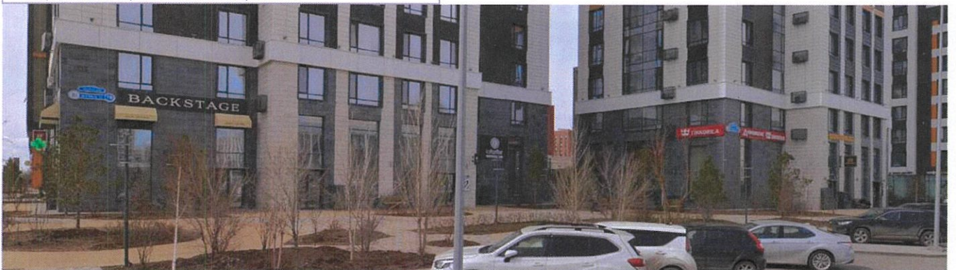
Қасбеттердің қазіргі жағдайының фотосуреті Фотофиксация текущего состояния фасадов
