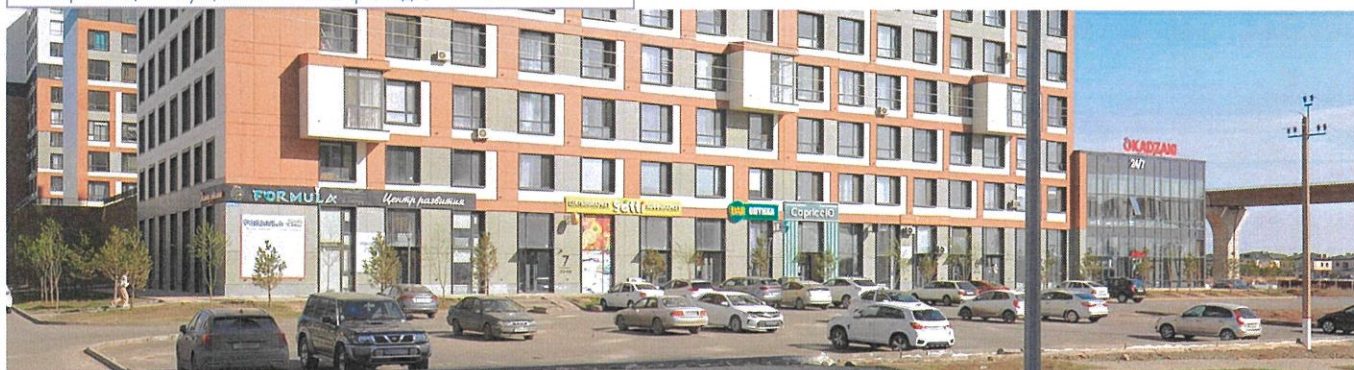
Қасбеттердің қазіргі жағдайының фотосуреті Фотофиксация текущего состояния фасадов
