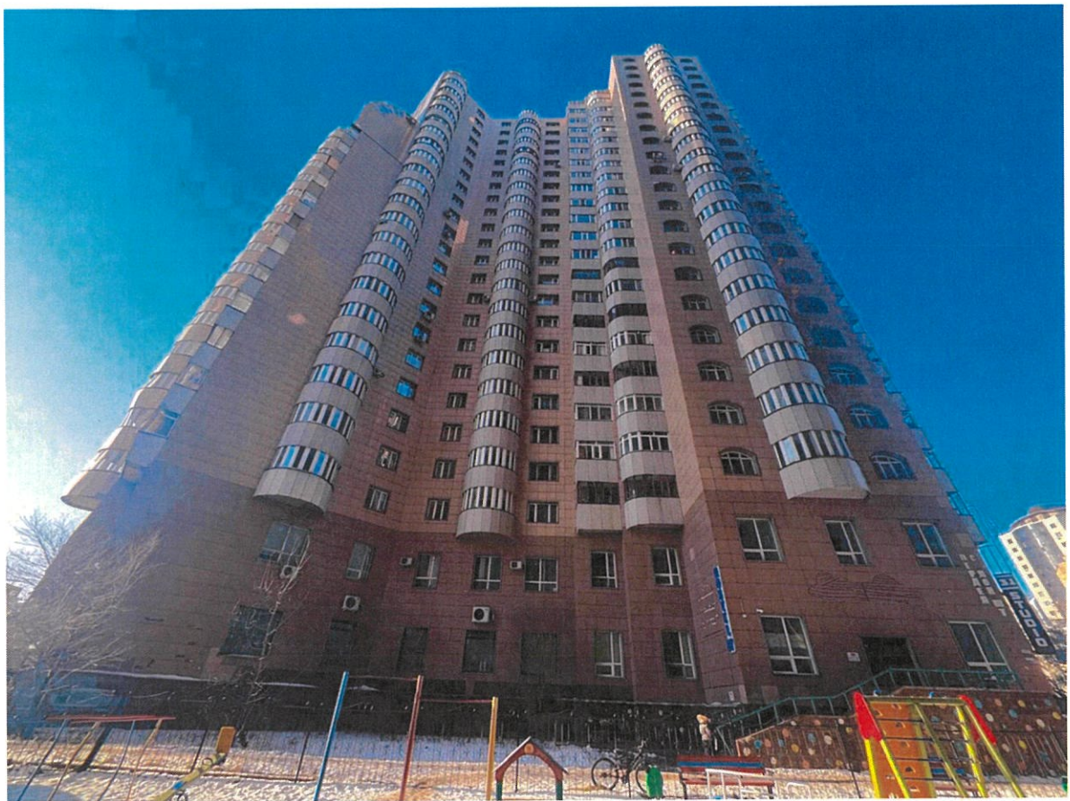
Восточный фасад здания по пр.Амангельды Иманов
