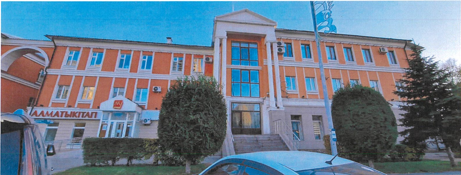
Северный фасад по улице Иманов.
