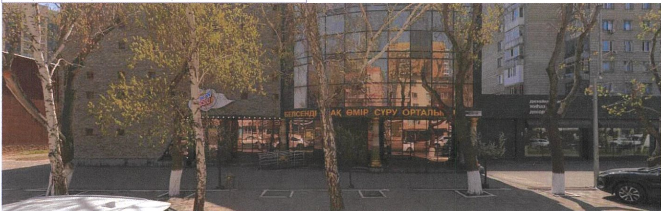
Қасбеттердің қазіргі жағдайының фотосуреті Фотофиксация текущего состояния фасадов
