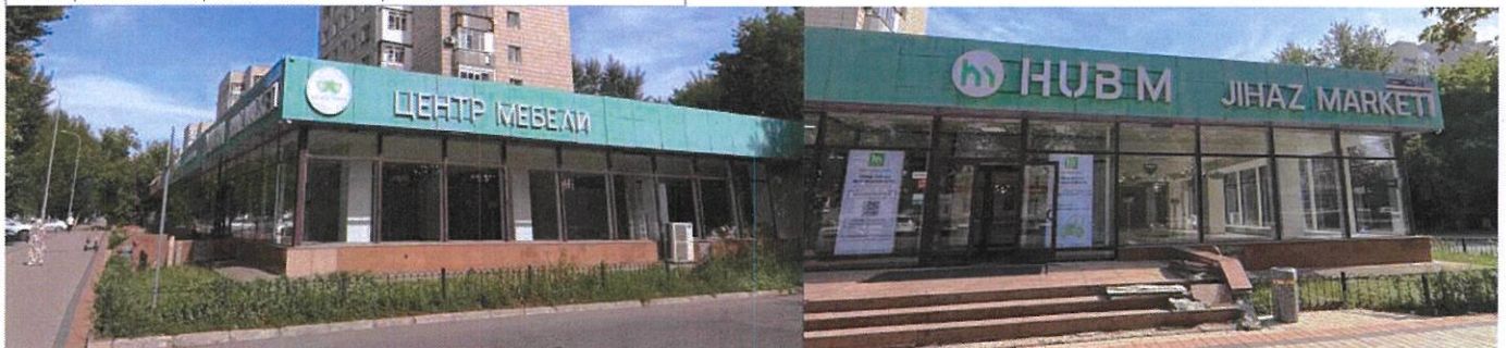
Қасбеттердің қазіргі жағдайының фотосуреті Фотофиксация текущего состояния фасадов
