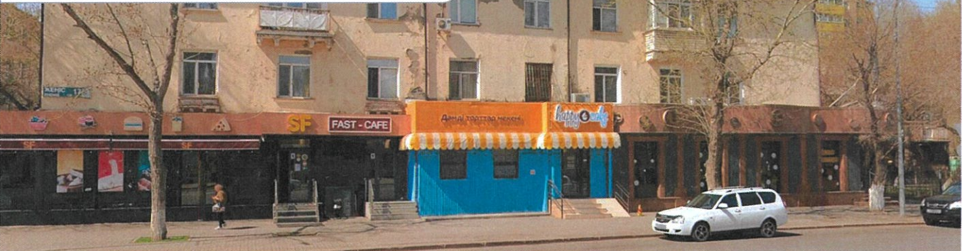
Қасбеттердің қазіргі күйін фотофиксациялау Фотофиксация текущего состояния фасадов
