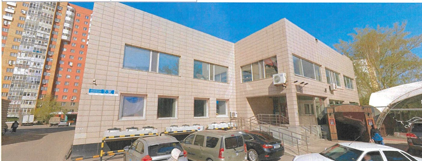
Қасбеттердің қазіргі жағдайының фотосуреті Фотофиксация текущего состояния фасадов
